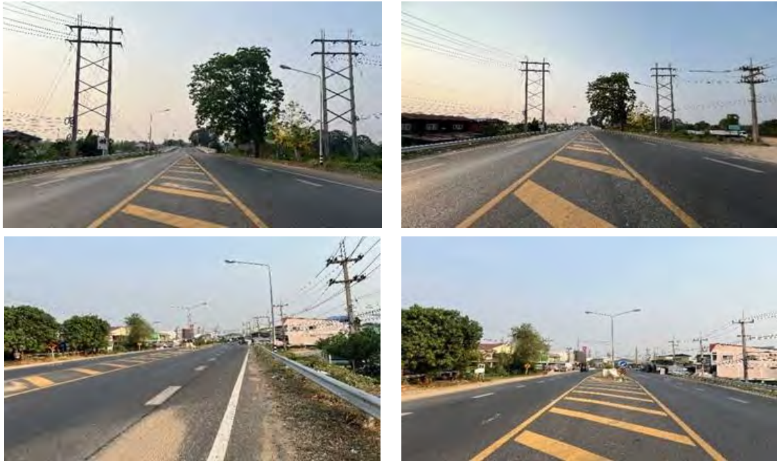
รูปที่ 4 สภาพปัจจุบันจุดสิ้นสุดโครงการ กม.139+461 บนทางหลวงหมายเลข 214
