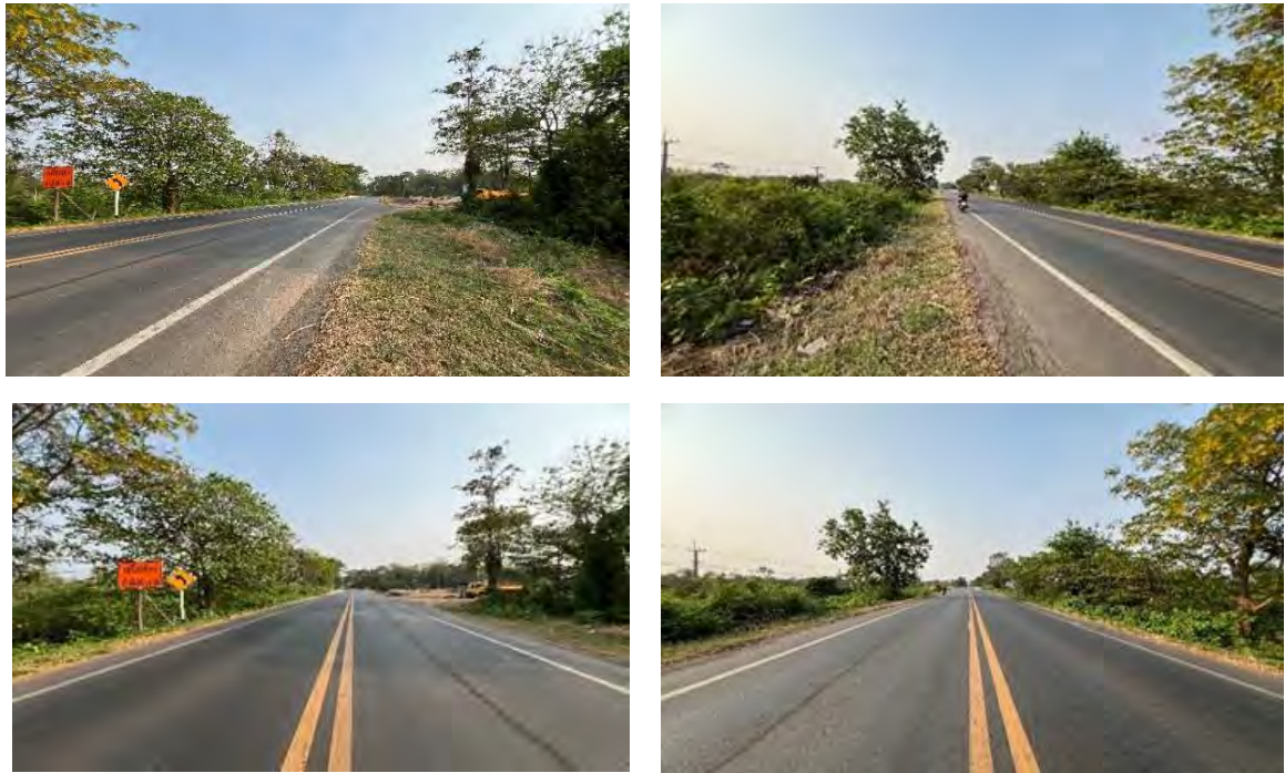
รูปที่ 2 สภาพปัจจุบันจุดเริ่มต้นโครงการ กม.137+200 บนทางหลวงหมายเลข 214
