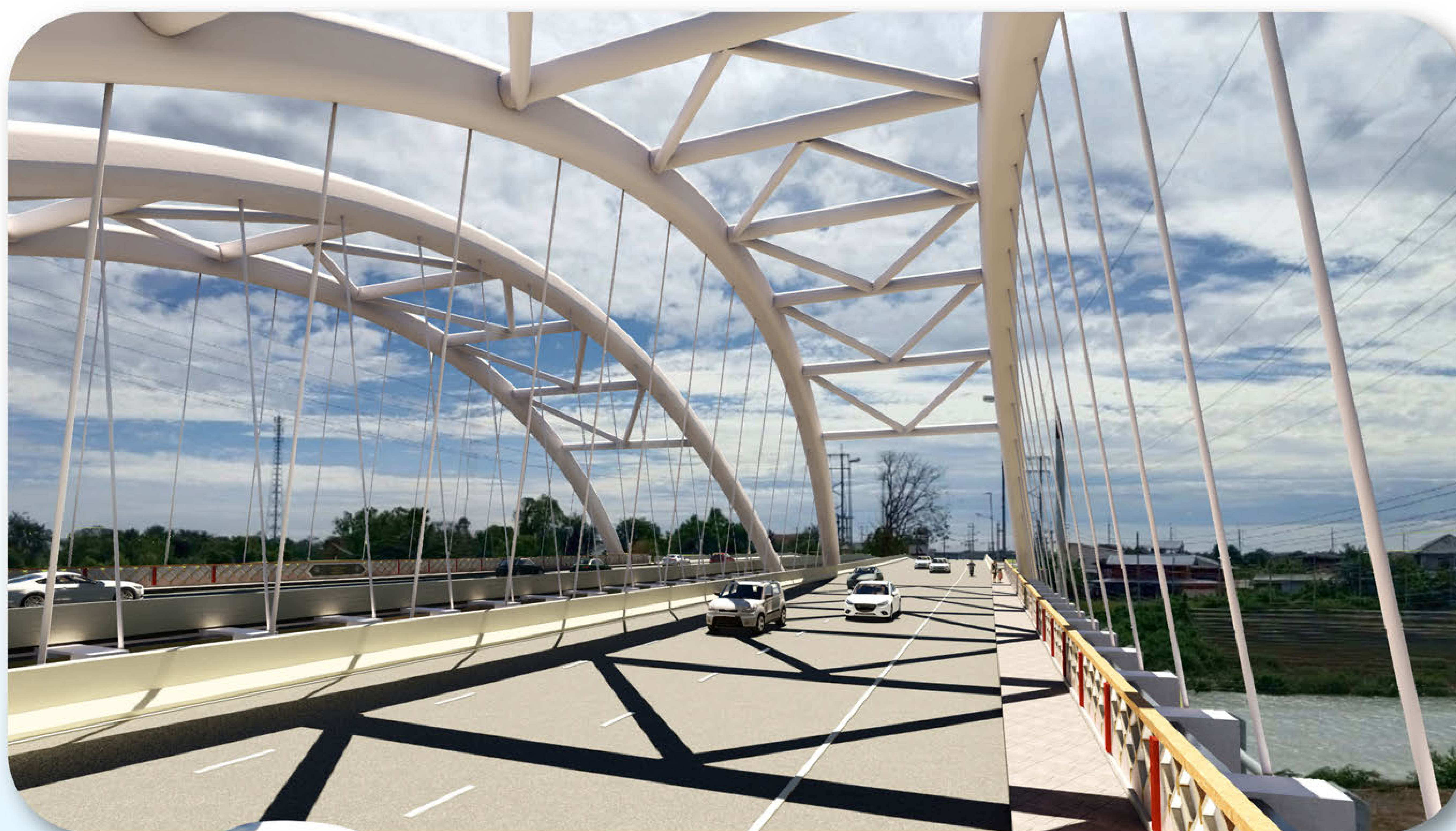
รูปแบบโครงสร้างสะพานโค้ง (Tied-Arch Bridge)
