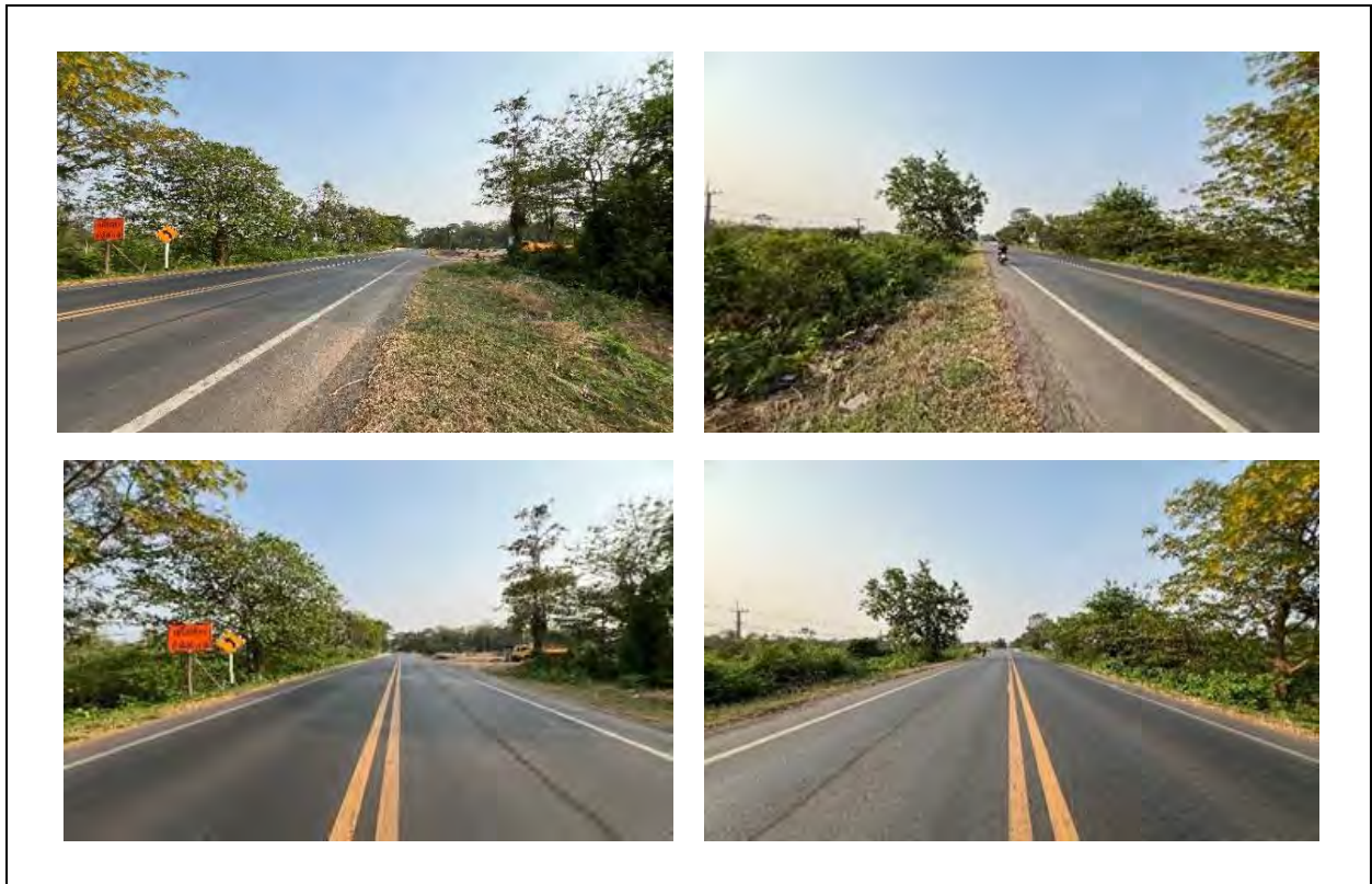
รูปที่ 2 สภาพปัจจุบันจุดเริ่มต้นโครงการ กม.137+200 บนทางหลวงหมายเลข 214
