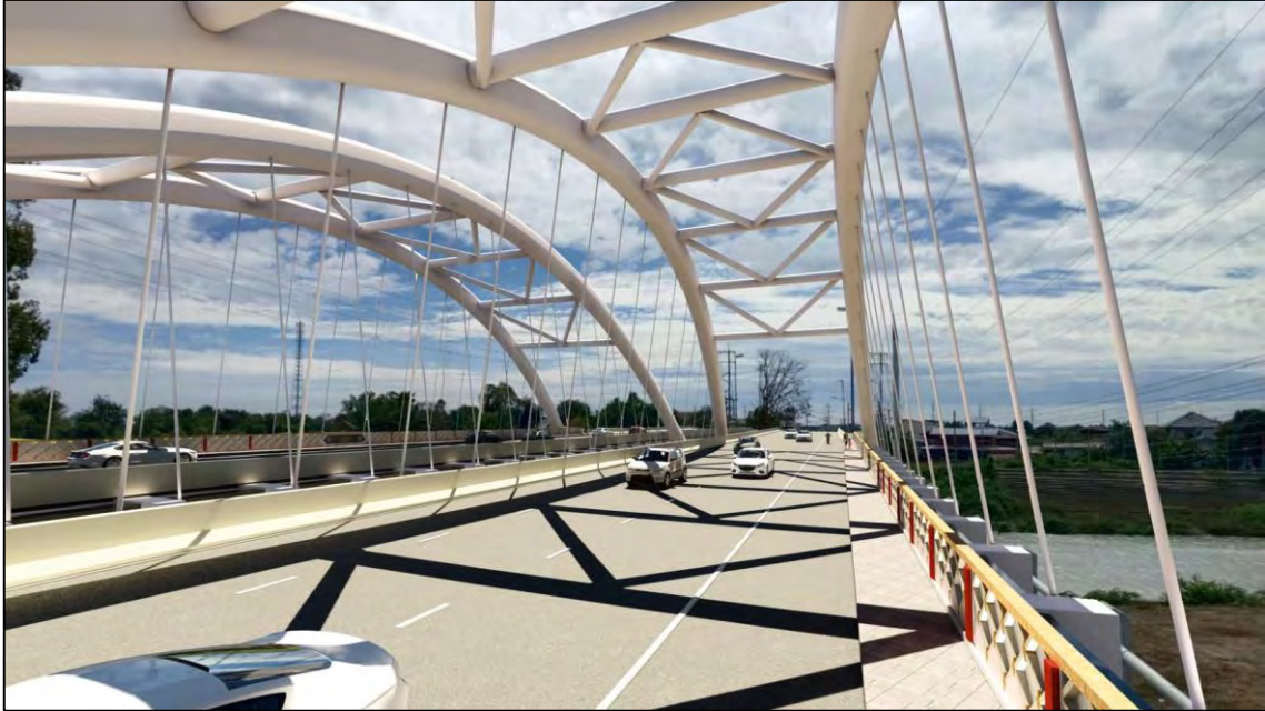
รูปที่ 6 สะพานแบบคานโค้ง (Tied-Arch Bridge)
